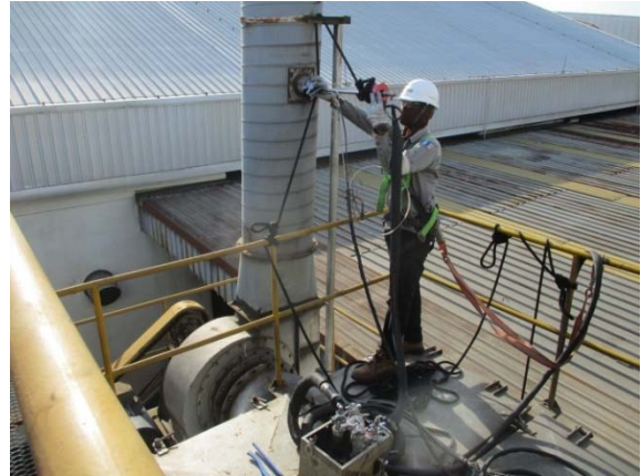
ตรวจวัดอากาศในปล่องระบายน
